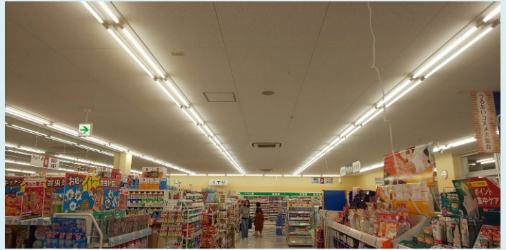
（施工例）ドラッグストア ベース照明にて使用
